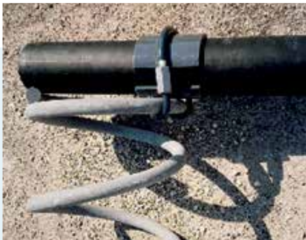
Slika 1.86. Pričvršćenje serijskog nosača na zavojnicu
