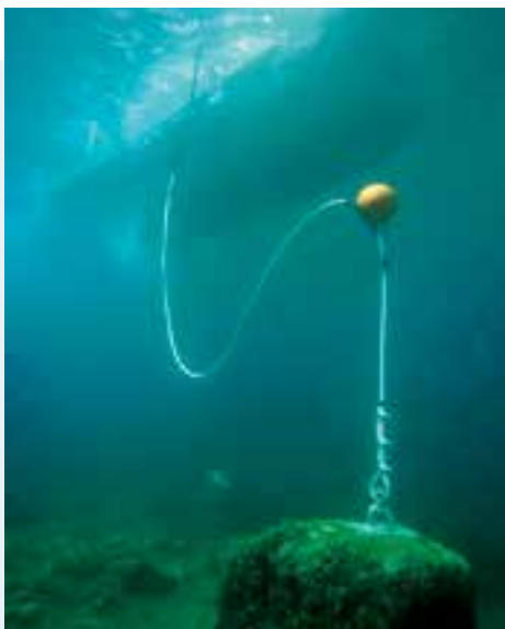
Slika 1.96. Primjena ubušenog sidra za grebene ekološke mreže Natura 2000
