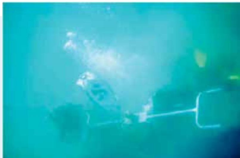
Slika 1.85. Instalacija sidra Harmony P® ručnom tehnikom
