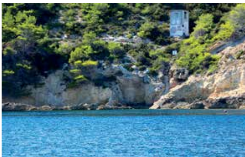
Slika 5.57. Kabelska kućica s oznakom na prilazu Mezuportu
