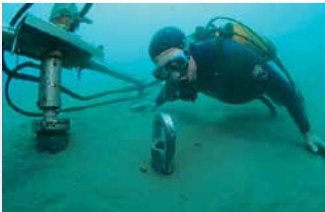
Slika 1.73. Glava vijka instaliranog u pijesku
