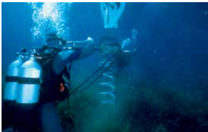
Slika 1.88. Instalacija Harmony P® sidra pomoću hidrauličnog stroja
